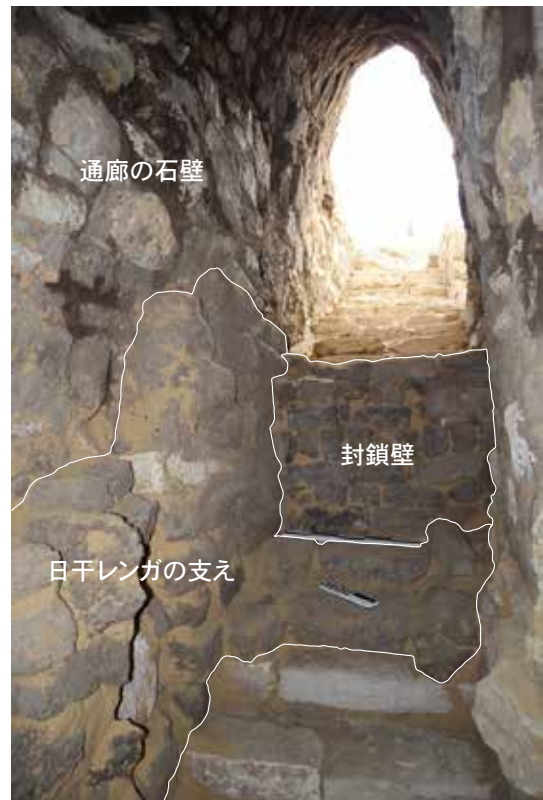
写真 18 石壁を支える古代に作られた 日干レンガの構造物 Pl.18 Ancient restorations by mud-brick wall inside the vaulted structure
